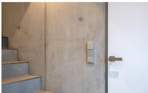
Die Modelle besitzen ein zweiteiliges Zargensystem. So ist ein rissfreier Wandanschluss möglich und die Gewerke können bei Neubau oder Sanierung unabhängig voneinander arbeiten. Zudem wird keine Vergrößerung der Wandöffnung benötigt, wodurch aufwändige Stemmarbeiten im Neubau und bei der Renovierung entfallen.
