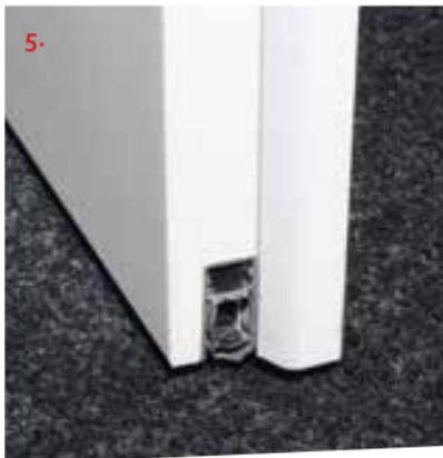
5. Absenkbare Bodendichtung
